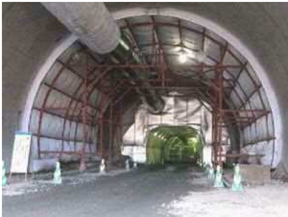
写真 5.3.1 保湿養生（バルーン養生）の事例 18)
