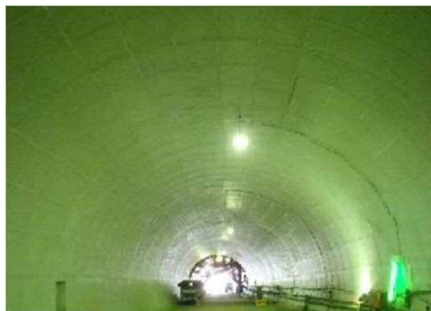
写真 5.3.5 シート養生の事例 21)
