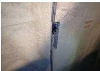
写真-2.2.1 覆工コンクリート表面の状況(S006)
