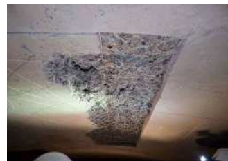
写真-2.2.3 覆工コンクリート表面の状況(S031)
