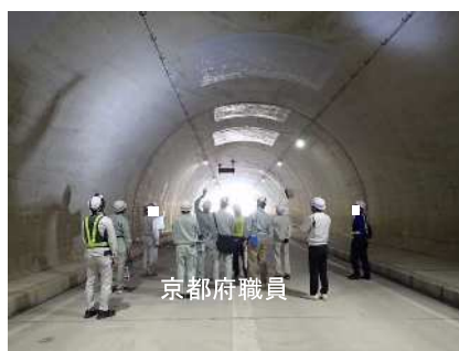
工事完成検査 (現場立会確認)
