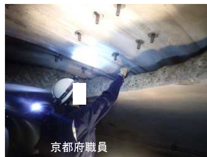
S038+0.7の止水材及び覆工厚の確認
