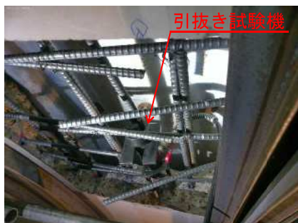
引抜き試験実施状況 5.00KN≧3.47kN
