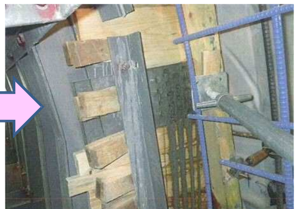
写真 7.1.20 ブリーディング水の排出状況
