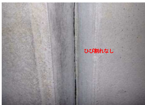
写真 7.1.25 付着低減剤の塗布ありの場合 32) に加筆
