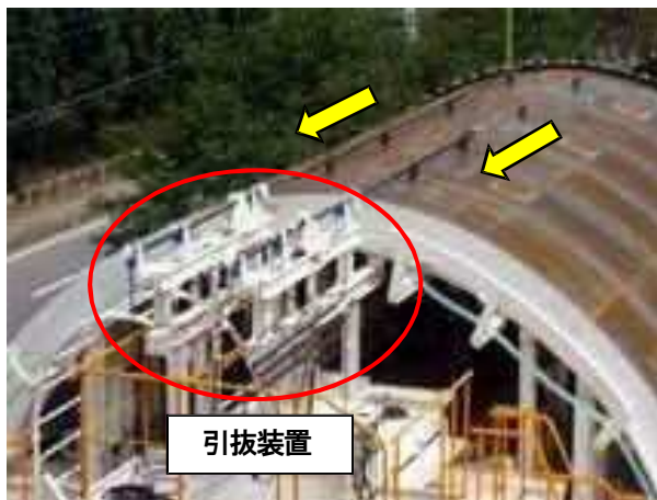
写真 7.1.7 天端引抜きバイブレーターの事例 48) に加筆
