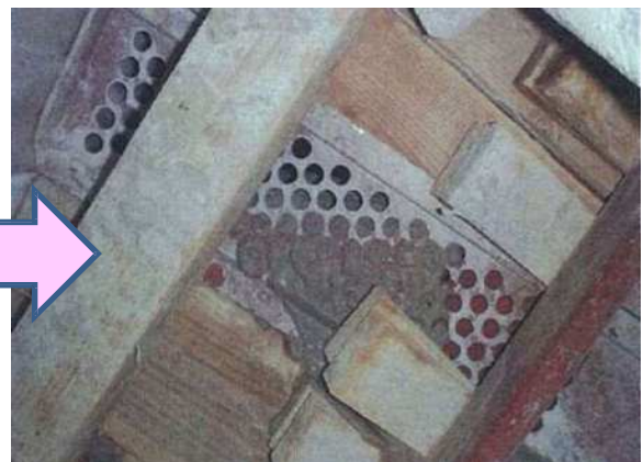
写真 7.1.18 ブリーディング水の排出状況
