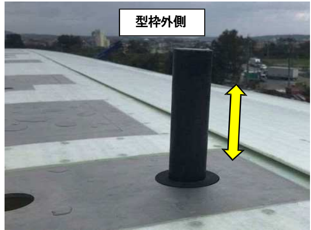
写真 7.1.8 伸縮式バイブレーター 45)に加筆
