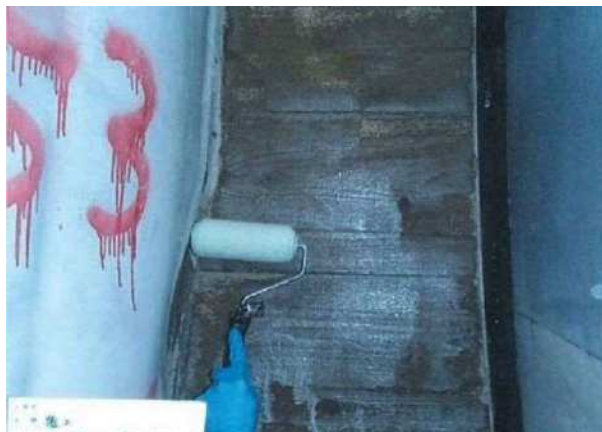
写真 7.1.23 既設目地部への付着低減剤の塗布 32)
