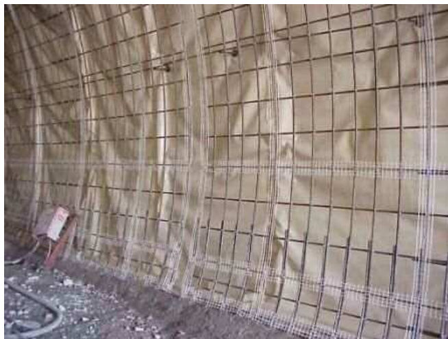
写真 7.1.29 トンネル覆工コンクリートへの施工事例 35)
