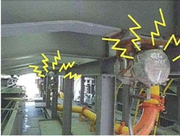
写真 7.1.9 型枠振動バイブレーター 46)に加筆
