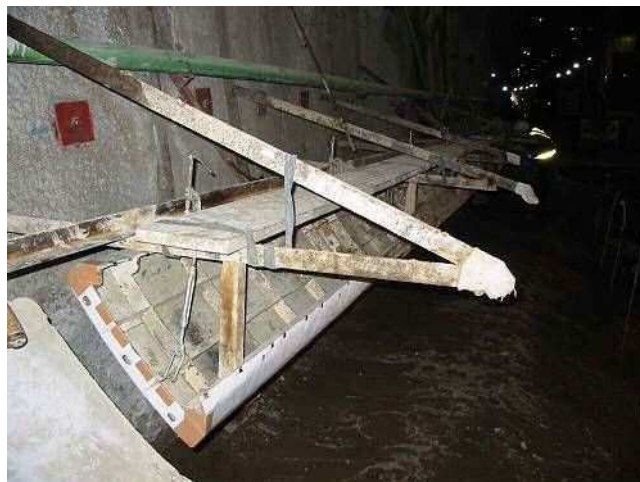
写真 7.1.10 型枠への貼付け状況 30)
