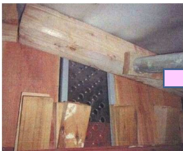
写真 7.1.3 透明妻型枠の状況（充填前）
