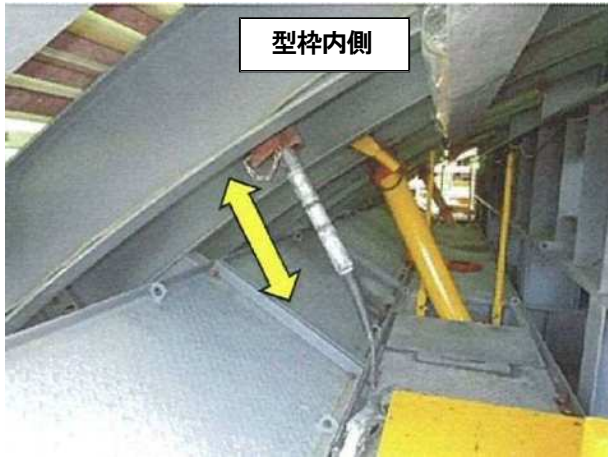
写真 7.1.8 伸縮式バイブレーター 45)に加筆
