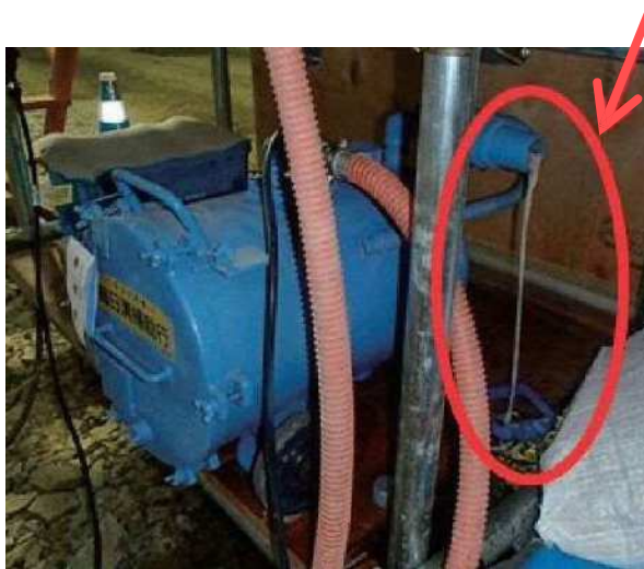
写真 7.1.21 ブリーディング水の排出状況 13)
