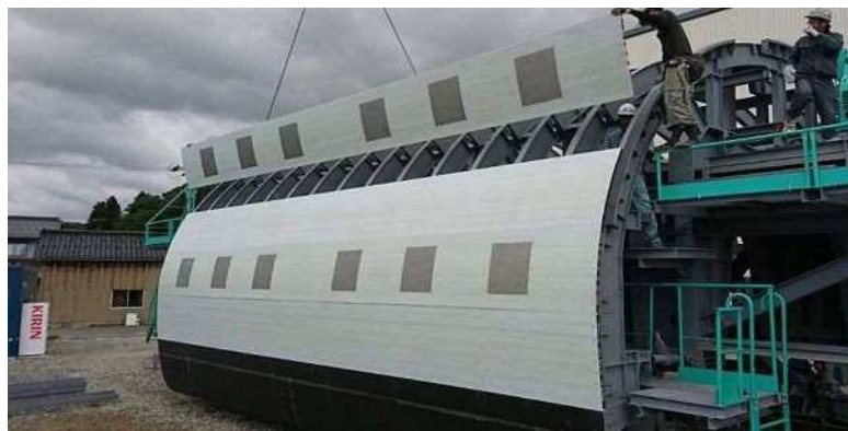
写真 7.1.14 セトルへの取付け状況 44)
