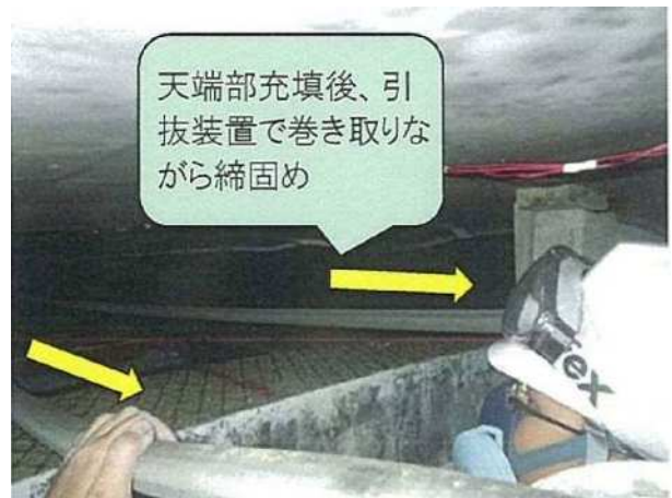
写真 7.1.7 天端引抜きバイブレーターの事例 48) に加筆
