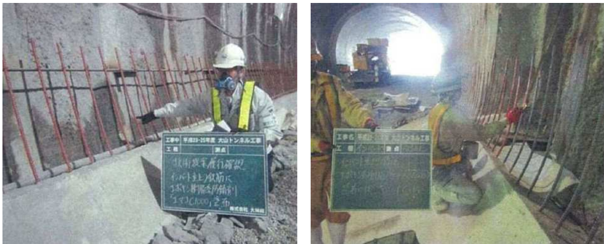
写真 7. 1. 30 トンネルにおける補強鉄筋への防錆塗装の施工事例
