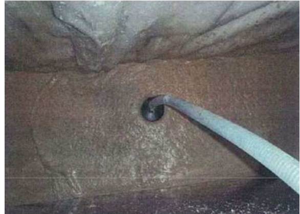
写真 7.1.16 バキュームポンプによる除去
