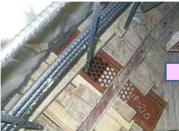
写真 7.1.17 鋼製パンチングメタルの事例
