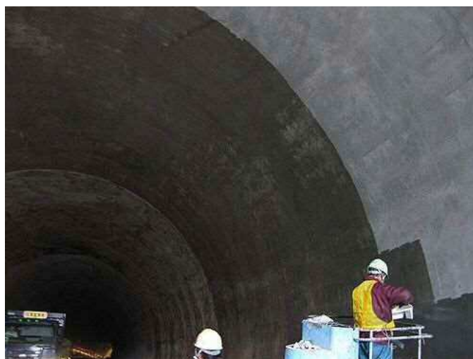
写真 7.1.27 トンネル覆エコンクリートへの施工事例 28)
