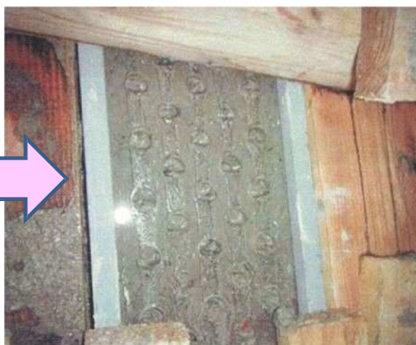
写真 7.1.4 透明妻型枠の状況（充填後）
