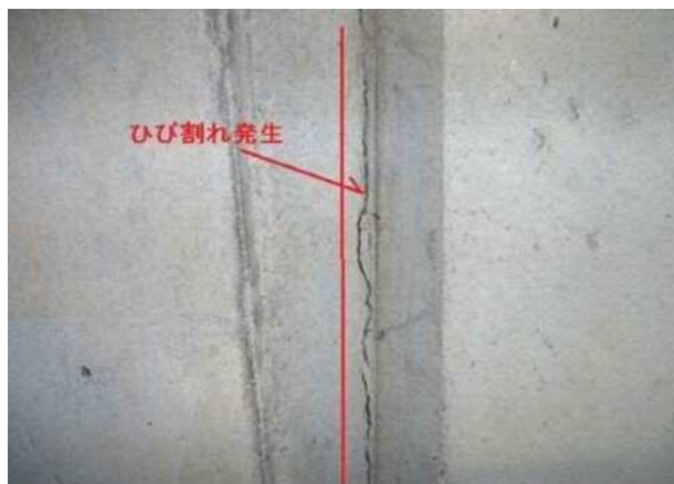
写真 7.1.24 付着低減剤の塗布なしの場合 32)
