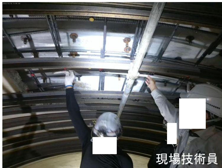
S038+5.9 D19ラップ長 720\text{mm} \geq 680\text{mm}
