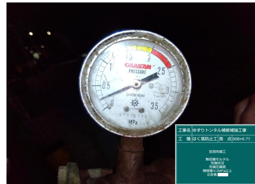
S008+0.71 注入圧確認 (実績0.2MPa以上 ≥ 設計0.2MPa)
