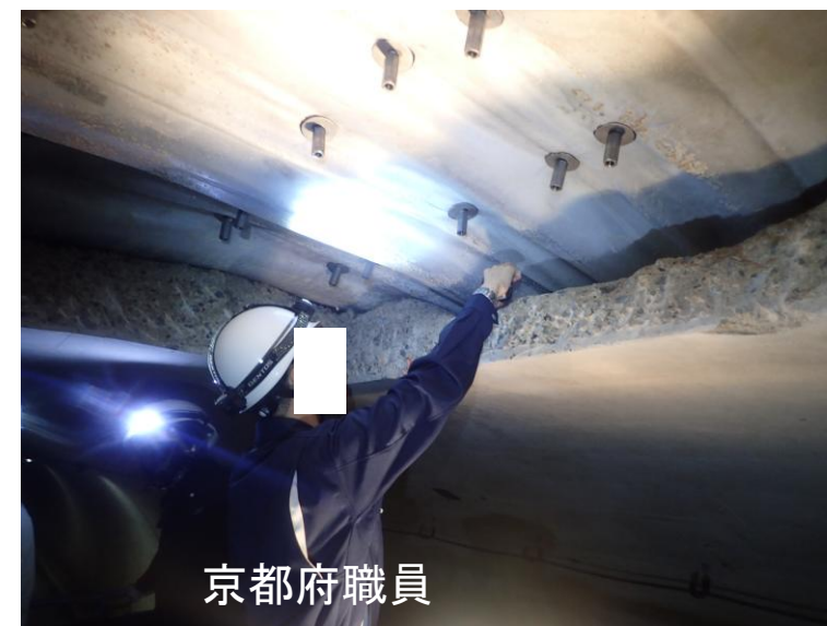
S038+0.7の止水材及び覆工厚の確認
