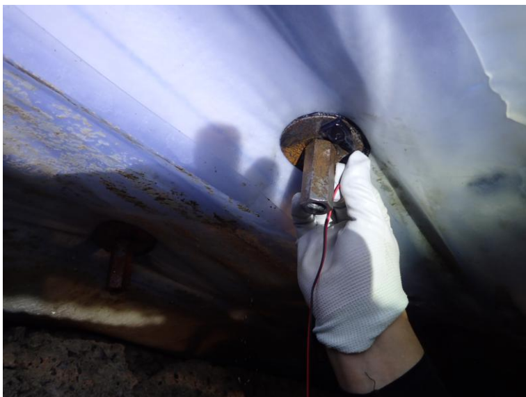
S038+5.9 充填検知センサー設置状況
