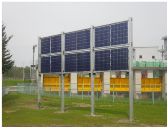
図 15 垂直型太陽光発電 （出所）北海道企業局
