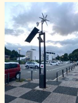
小型太陽光+マイクロ風力発電設備のイメージ(あそびあむ周辺)
