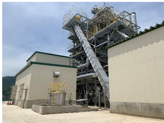
図５ ２０２０年４月から稼働している舞鶴市内の木質バイオマス発電所
