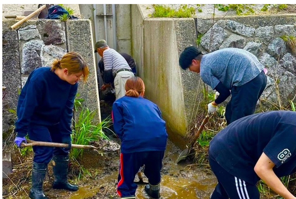
水路清掃の様子
