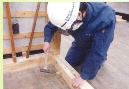
木造基礎実習
