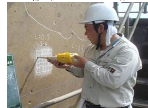
老朽化した施設の機能診断
