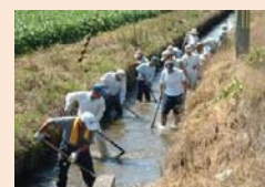
水路の泥上げ
