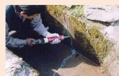
水路のひび割れ補修
