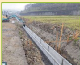
用水路の改修
