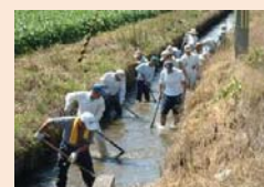
水路の泥上げ
