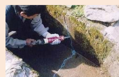
水路のひび割れ補修
