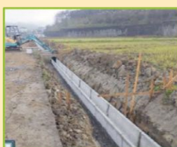
用水路の改修
