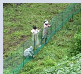
獣害防止ネット設置作業
