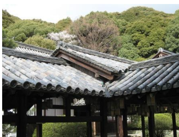
萬福寺（宇治市） 重要文化財・大雄宝殿の回廊屋根修理
