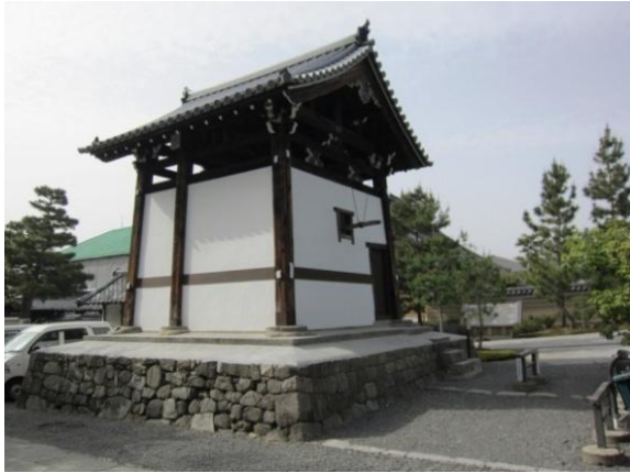
建仁寺・大鐘楼（東山区） 府指定文化財・大鐘楼 解体修理
