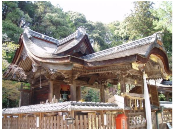
鋤山神社・本殿（亀岡市） 府登録文化財・本殿等 軒裏修理
