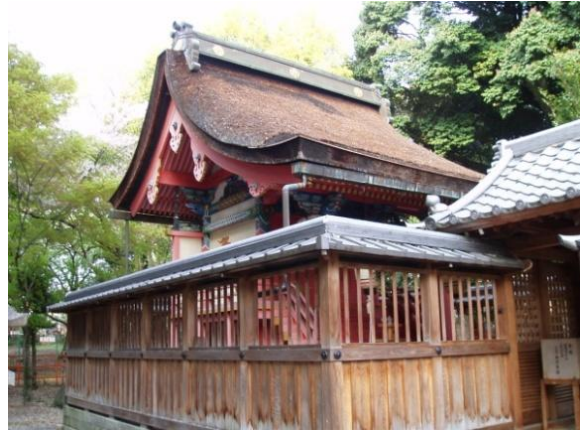
巨椋神社・本殿（宇治市） 府登録文化財・本殿 屋根檜皮葺修理
