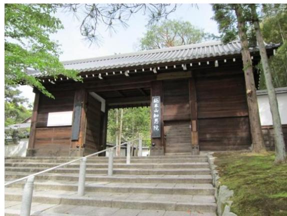
知恩院・黒門（東山区） 府指定文化財・黒門 半解体修理
