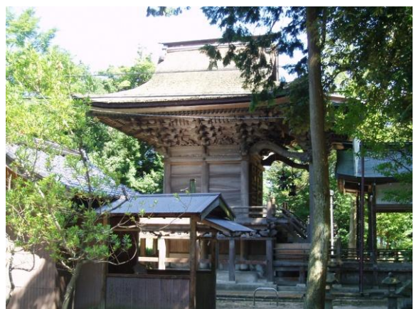
神谷神社・本殿（京丹後市） 府指定文化財・本殿 屋根等修理
