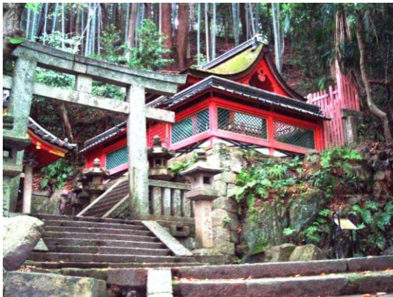
石清水八幡宮・石清水社（八幡市） 府指定文化財・石清水社 瑞垣の屋根瓦修理
