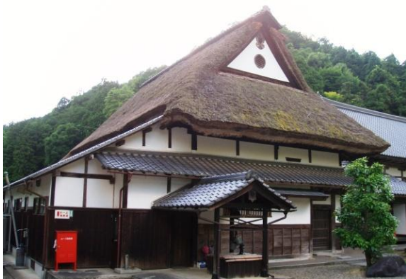
安国寺・庫裏（綾部市） 府登録文化財・庫裏 屋根等修理
