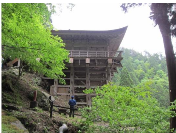
峰定寺・本堂（左京区） 重要文化財・本堂 消防設備復旧
