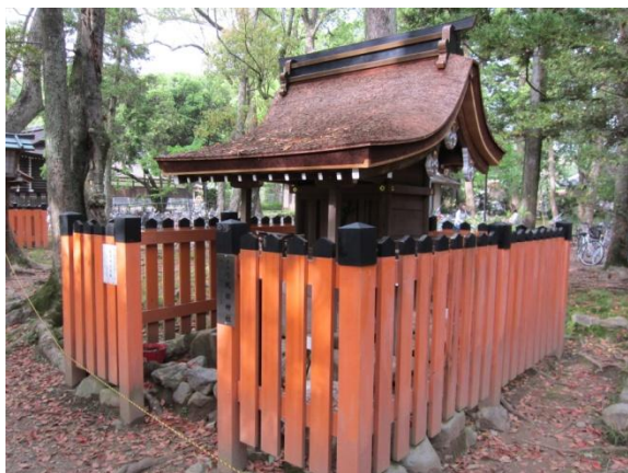
上賀茂神社・末社梶田社（北区） 屋根檜皮葺修理
