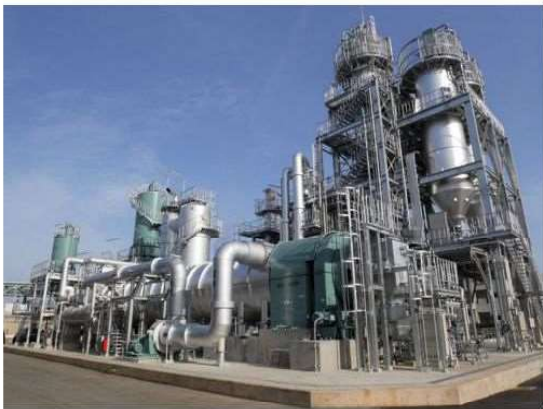
固形燃料化施設全景
