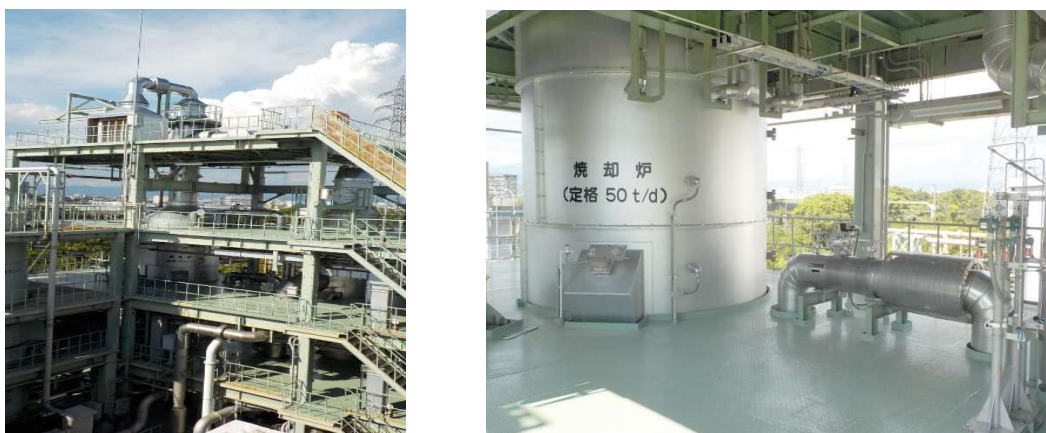
図 5.2 3号焼却炉（左：全景、右：焼却炉本体）
