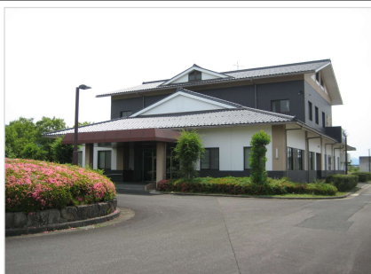
綾部市 綾部浄化センター
