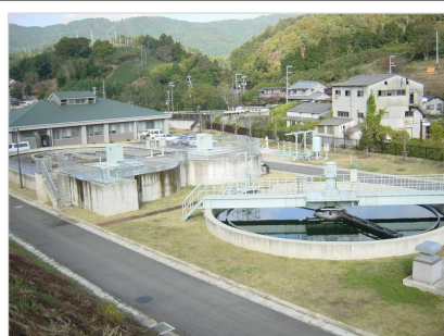
和束町 和束中央浄化センター
