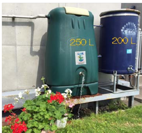
雨水貯留施設（府庁 2 号館屋上）
