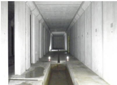
写真-1：貯留施設内部
