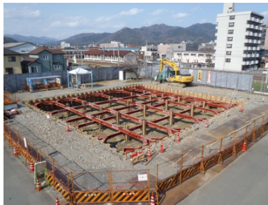
写真-2：工事の様子
