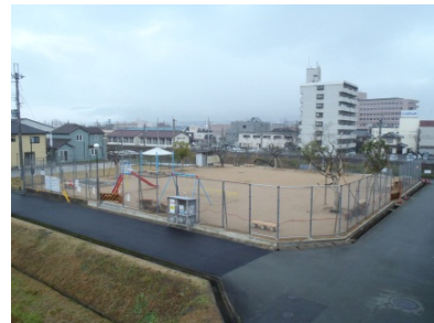
写真-3：公園リニューアル工事
