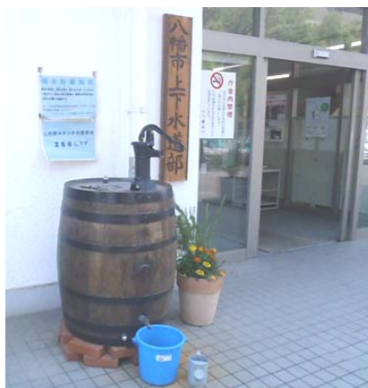
雨水貯留施設（八幡市上下水道部）
