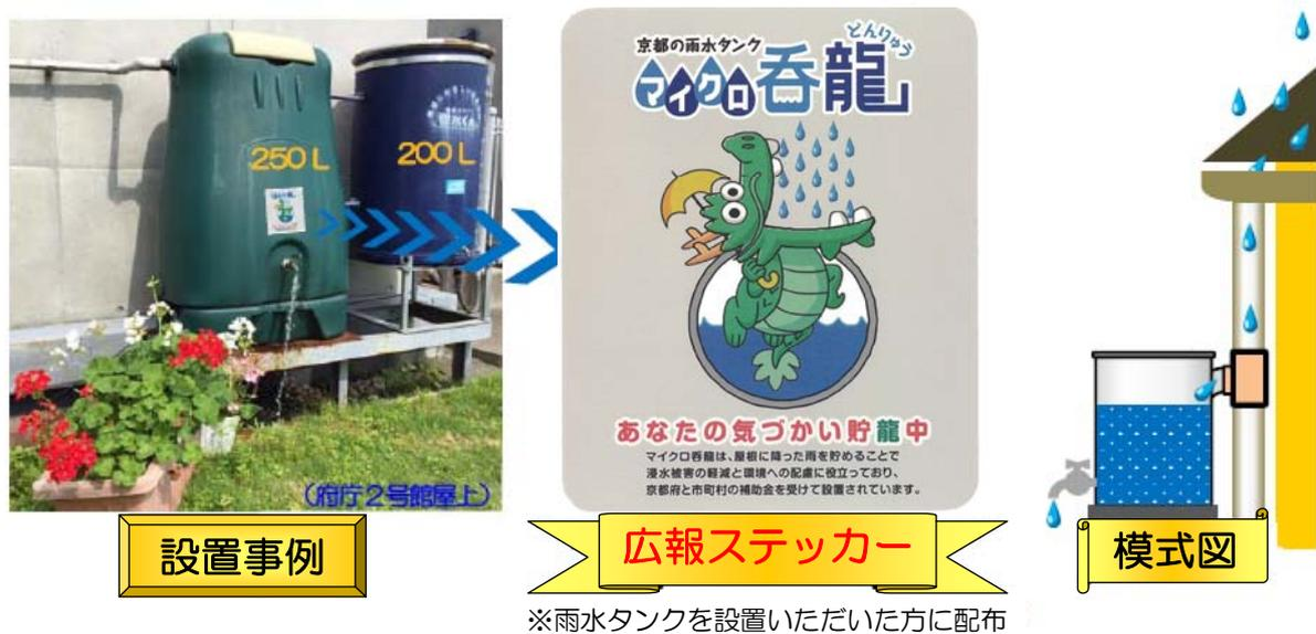
図 6-24 小型雨水貯留タンク（マイクロ呑龍）の設置例（出典：京都府ホームページ）
