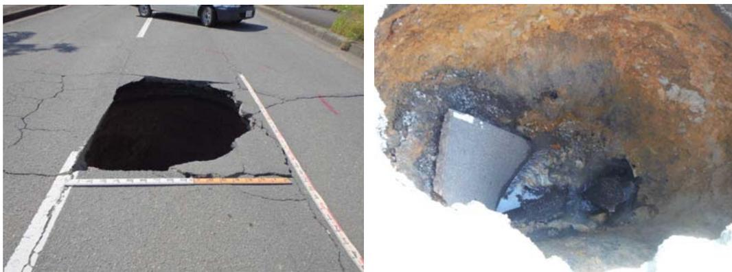
図 5-2 平成 27 年 5 月に発生した道路陥没事故（福知山市公共下水道）
