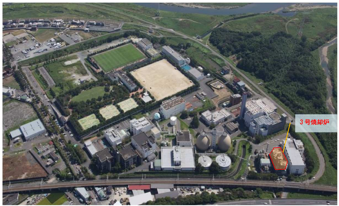
図 4.3 洛西浄化センター航空写真
