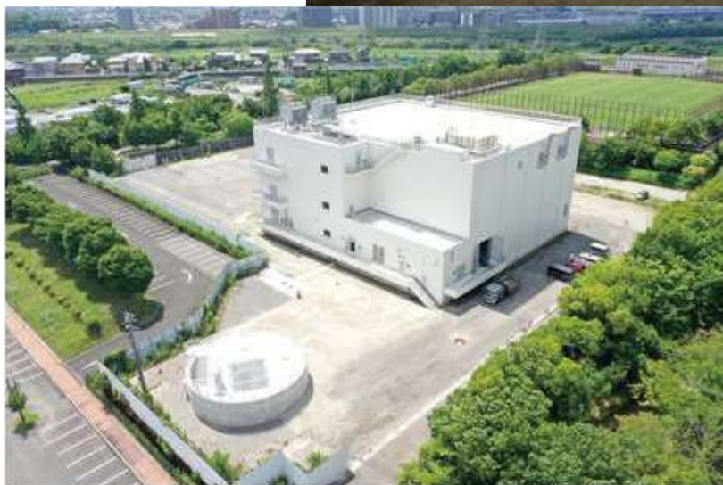
呑龍（どんりゅう）ポンプ場
