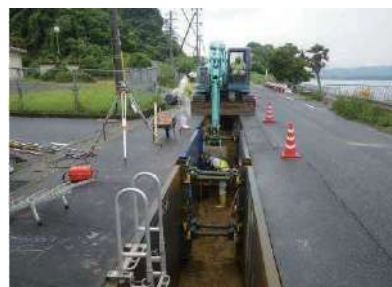
宮津湾流域 二条化工事
