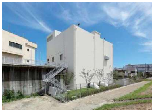
大山崎町 大山崎排水ポンプ場
