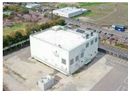
呑龍ポンプ場
