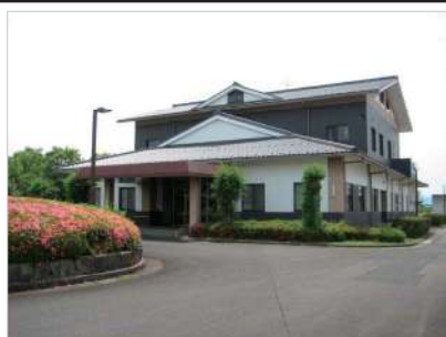
綾部市 綾部浄化センター
