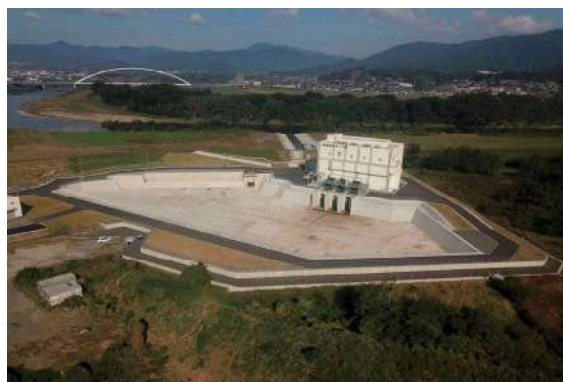
福知山市 段畑雨水ポンプ場
