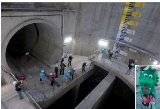
乙訓ポンプ場
