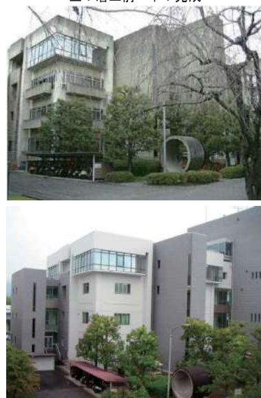
洛西浄化センター管理棟(南館)耐震化工事 上：着工前 下：完成
