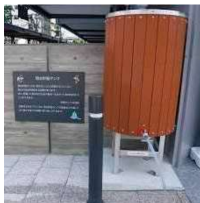
雨水貯留施設（京都市上下水道局）
