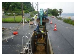
宮津湾流域 二条化工事
