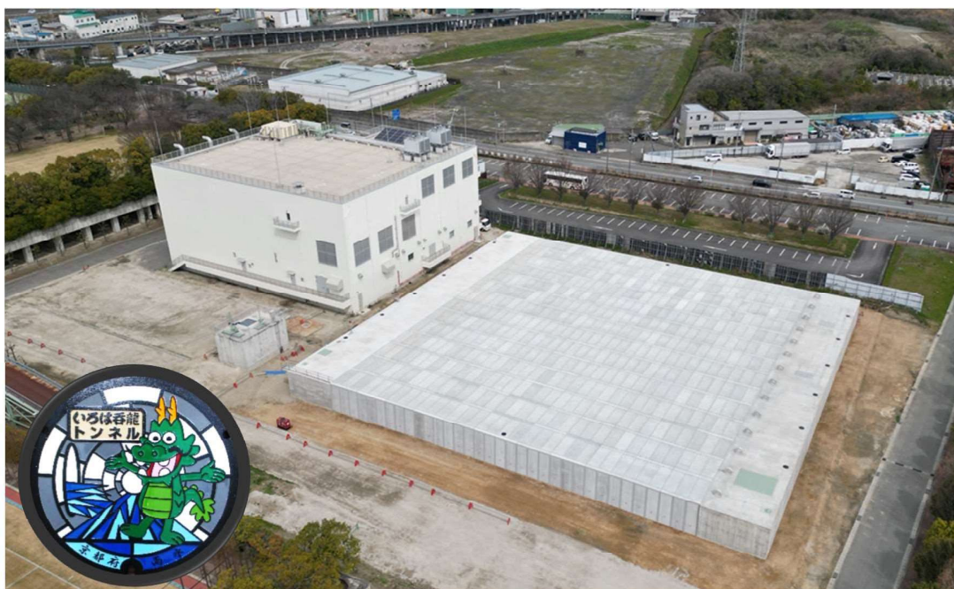
呑龍ポンプ場(左奥)と調整池(右手前)
