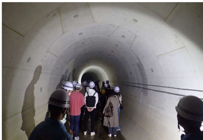
呑龍トンネル南幹線(R6.10.20 下水道フェア)
