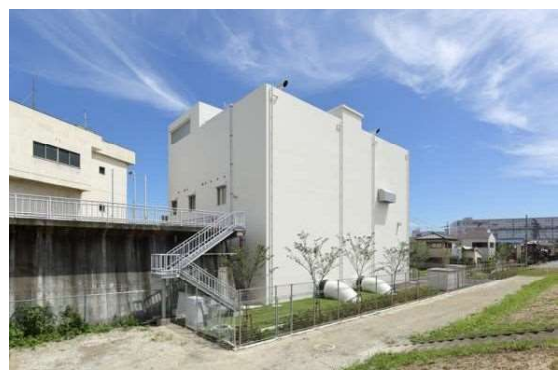
大山崎町 大山崎排水ポンプ場
