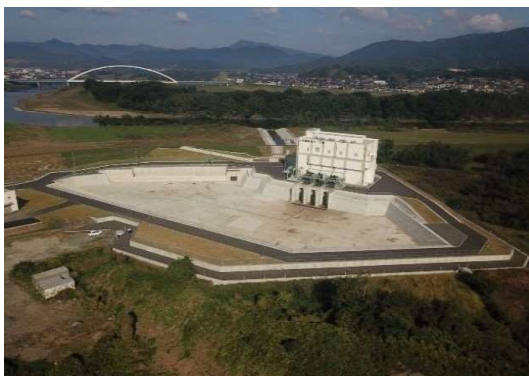
福知山市 段畑雨水ポンプ場
