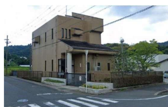
獅子崎中継ポンプ場
