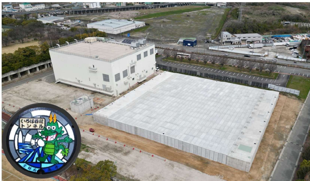
呑龍ポンプ場(左奥)と調整池(右手前)
