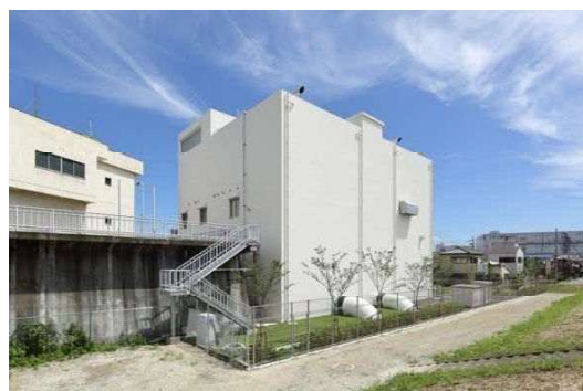
大山崎町 大山崎排水ポンプ場
