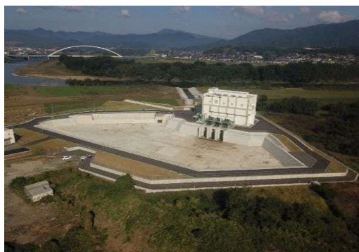
福知山市 段畑雨水ポンプ場
