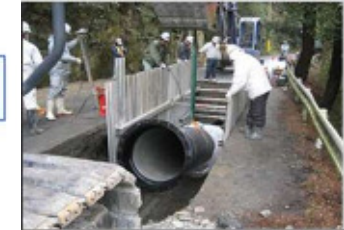
耐震管路の布設
