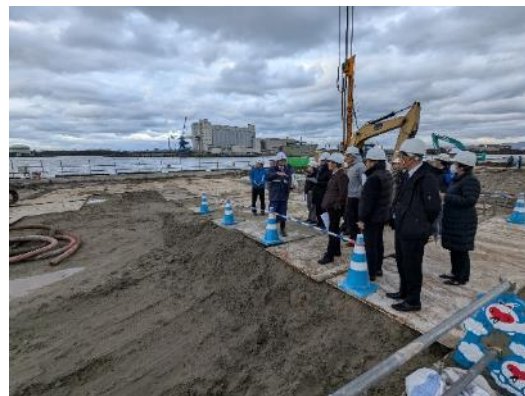
新潟港東港を視察
