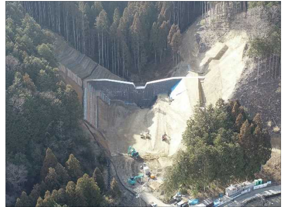
蛙ヶ谷川（京都市北区）砂防えん堤
