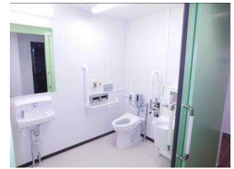
(3) 伏見港公園体育館トイレ
