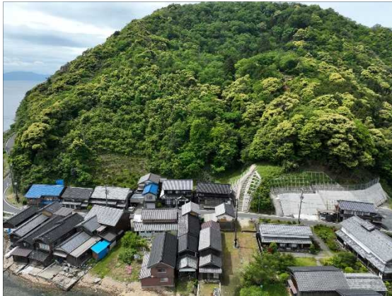
小坪（伊根町） 擁壁工
