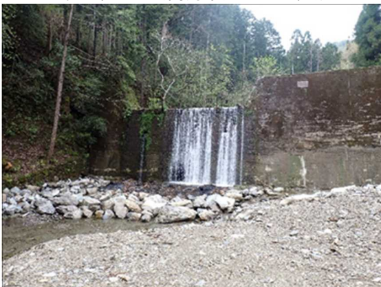
津の本谷川（南丹市） 砂防えん堤修繕
