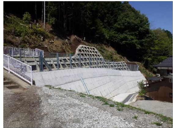
志高（舞鶴市） 擁壁工
