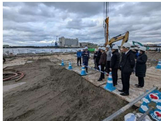
新潟港東港を視察
