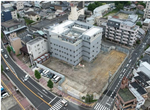
工事状況 (令和 7 年 6 月撮影)
