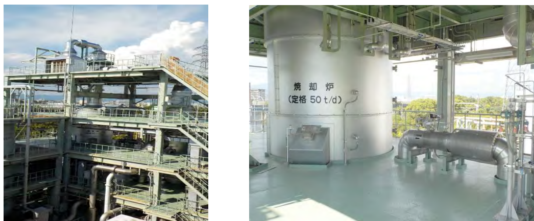
図 5.2 3号焼却炉（左：全景、右：焼却炉本体）
