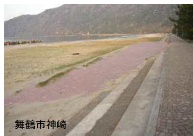
図 1-5-14 スロープの整備
