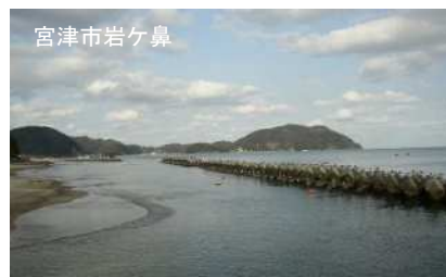
図 1-5-5 整備された海岸保全施設
