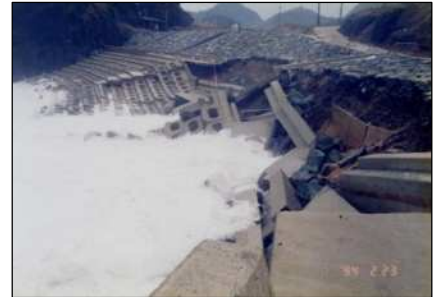
図 1-3-1 冬季風浪による海岸保全施設の被災
