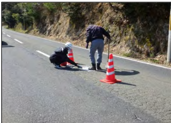
日常点検（道路パトロール）
