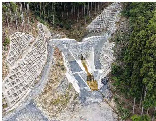
中ノ谷川（宇治田原町）砂防えん堤
