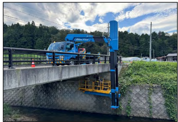
定期点検（橋梁点検）
