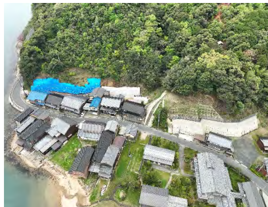
小坪(伊根町) 擁壁工
