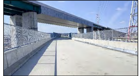
山城総合運動公園城陽線 （城陽橋 城陽市）
