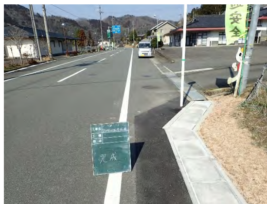
完成（側溝蓋の設置）
