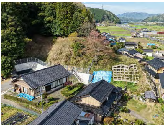
志高(舞鶴市) 擁壁工
