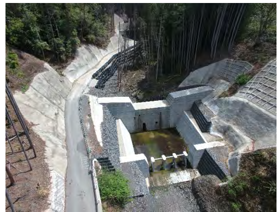
門前川（和東町）砂防えん堤
