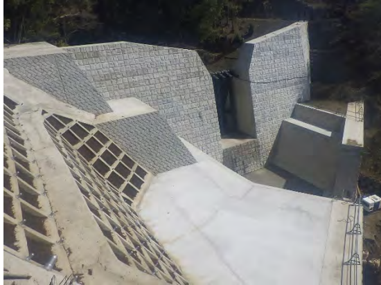
北川（京都市西京区）砂防えん堤
