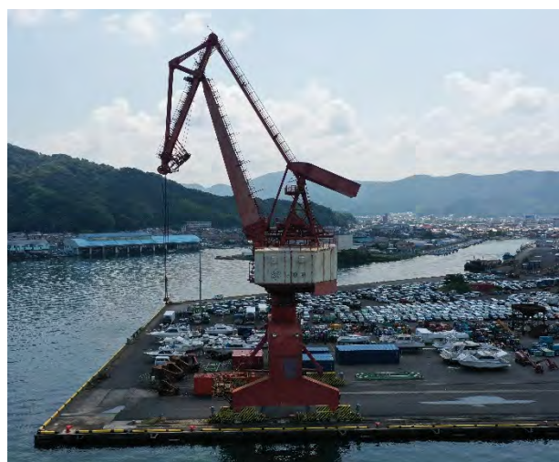
第2ふ頭の老朽化した多目的クレーンの更新
