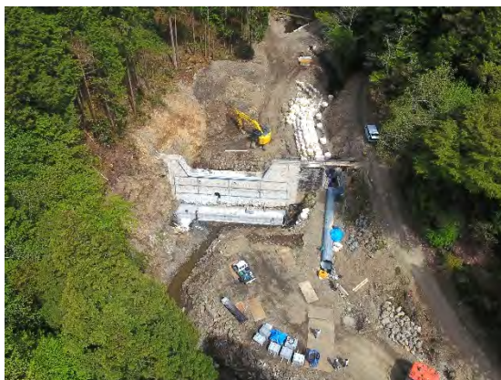
津の本谷川(南丹市) 砂防えん堤修繕
