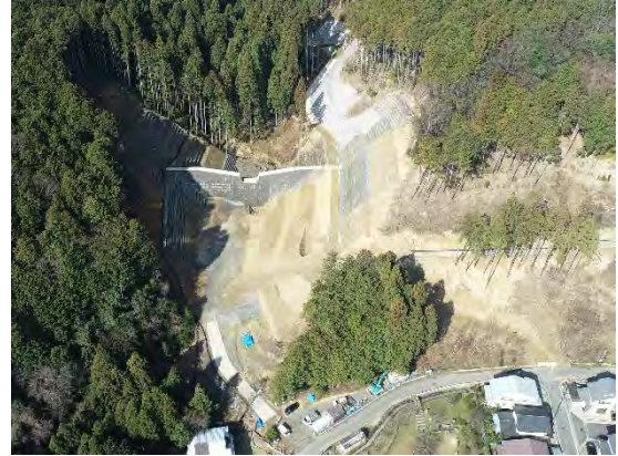
蛙ヶ谷川（京都市北区）砂防えん堤
