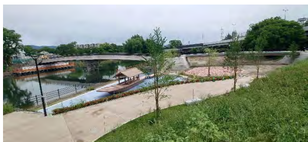
伏見みなと公園広場（完成部分）
