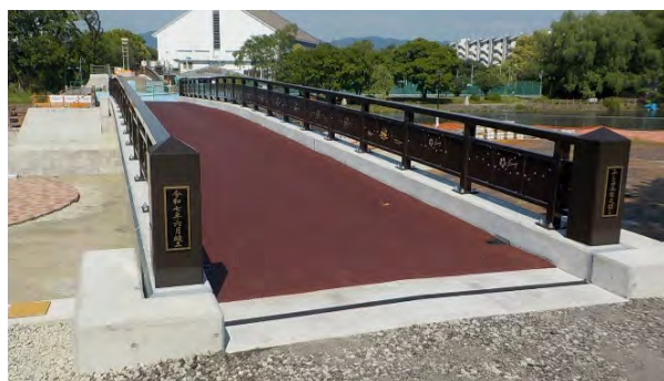
伏見みなと橋（延伸完了）
