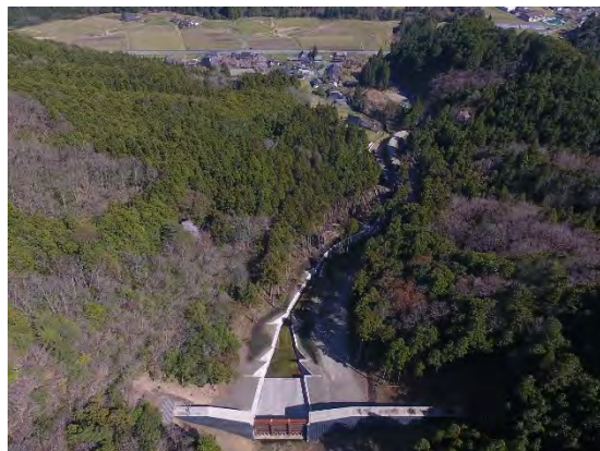
篠原西一谷川（京丹波町）砂防えん堤
