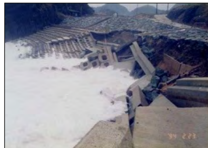
図 1-3-1 冬季風浪による海岸保全施設の被災
