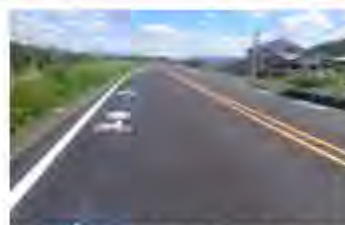
矢羽根・自転車ピクトの設置 (淀川リバーサイドサイクルライン)
