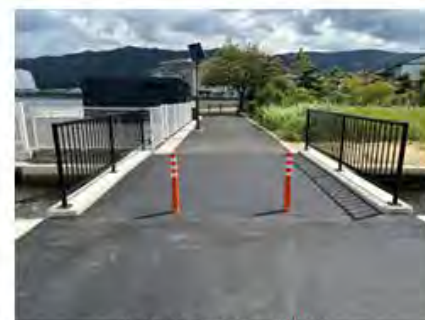
未接続区間の整備 （田井大垣自転車道線）
