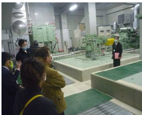
新荒河排水機場を視察
