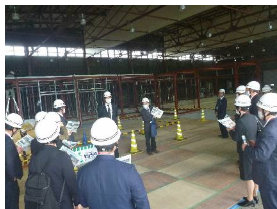
第2ふ頭の工事現場を視察
