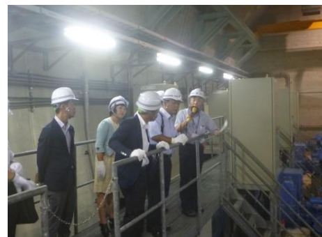
取水、導水ポンプ室を調査
