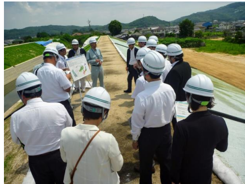
緊急対策工事の状況を視察
