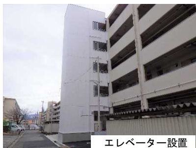
エレベーター設置
