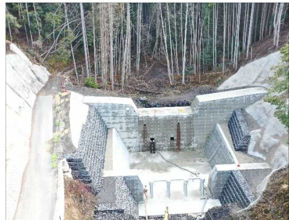
門前川（和束町）砂防えん堤
