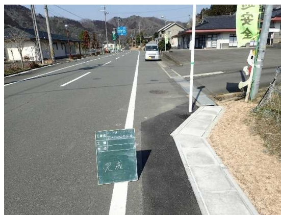
完成（側溝蓋の設置）
