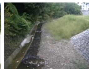
環境に配慮した護岸
