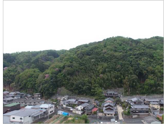
大野（木津川市） 法枠工
