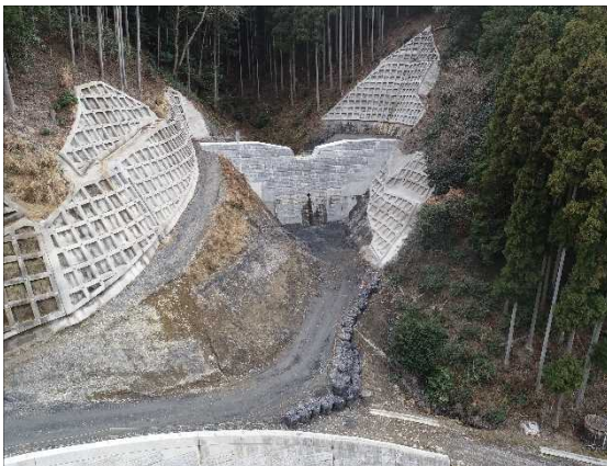
中ノ谷川（宇治田原町）砂防えん堤
