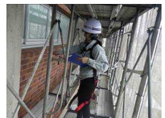
(5) 工事監理(外壁補修検査)
