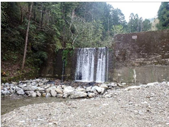
津の本谷川（南丹市） 砂防えん堤修繕
