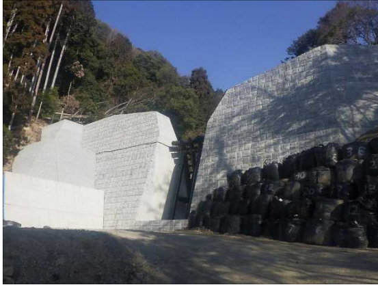
北川（京都市西京区）砂防えん堤
