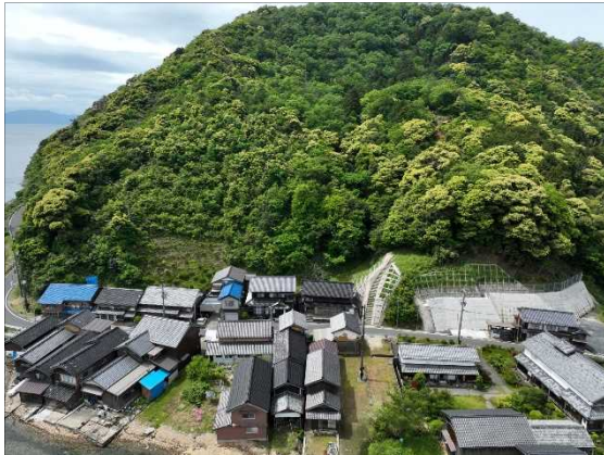
小坪（伊根町） 擁壁工
