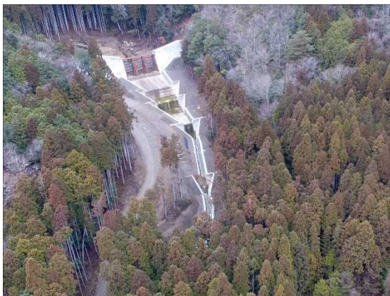
篠原西一谷川（京丹波町）砂防えん堤
