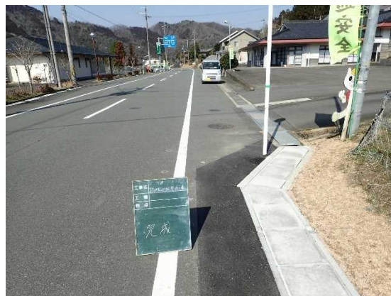
完成（側溝蓋の設置）
