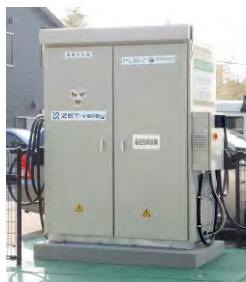
リユースバッテリーを使用した EV急速充電器
