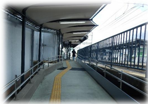
鉄道駅舎バリアフリー化設備整備事業 (近鉄山田川駅下りスロープ整備)
