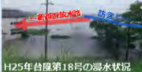
H25年台風第18号の浸水状況
