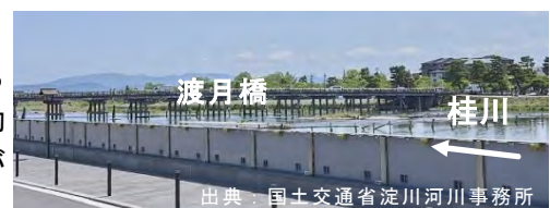
桂川嵐山地区左岸溢水対策（可動式止水壁）
