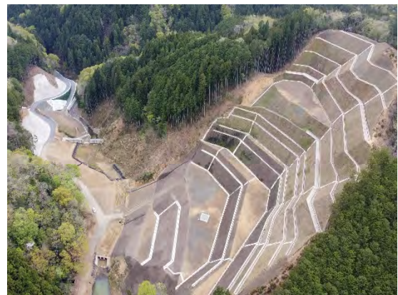
谷河川（福知山市）斜面崩壊箇所の対策工事
