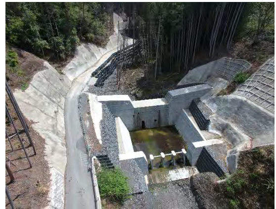
門前川（和東町）砂防えん堤
