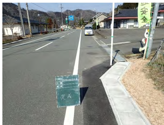
完成（側溝蓋の設置）
