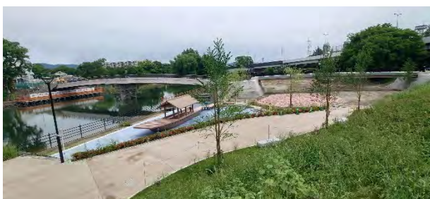
伏見みなと公園広場（完成部分）
