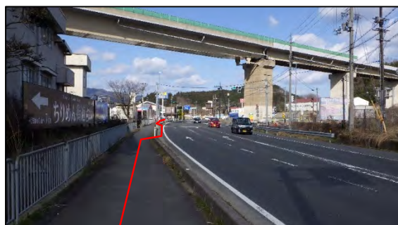
加悦谷第1幹線二条管増設箇所
