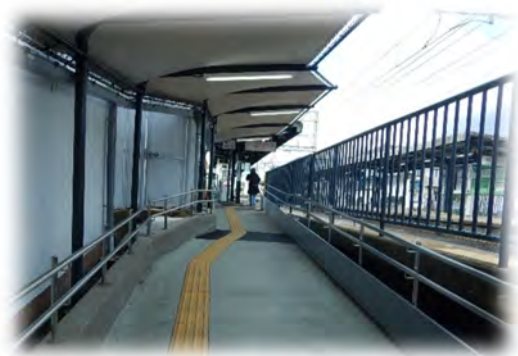
鉄道駅舎バリアフリー化設備整備事業 (近鉄山田川駅下りスロープ整備)
