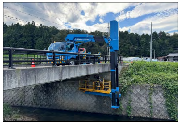
定期点検（橋梁点検）
