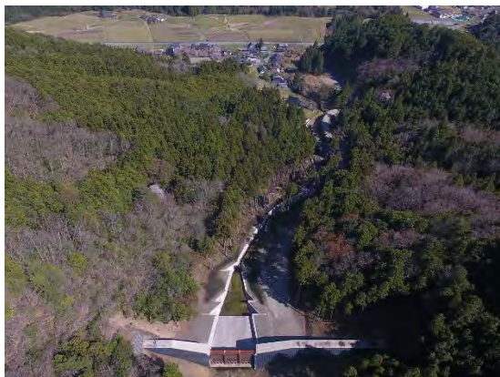
篠原西一谷川（京丹波町）砂防えん堤
