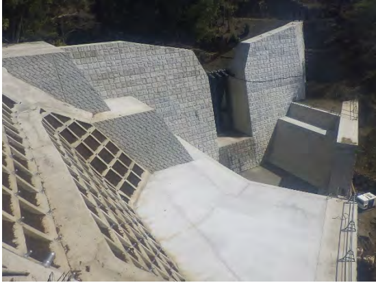
北川（京都市西京区）砂防えん堤
