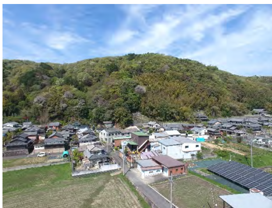
大野(木津川市) 法枠工
