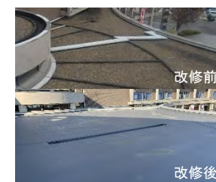
(6) けいはんなプラザ (防水改修)
