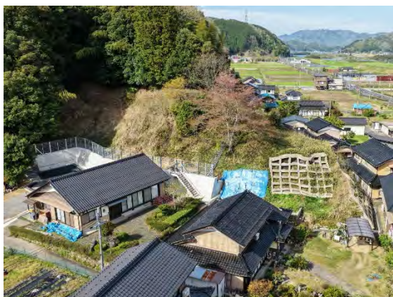
志高(舞鶴市) 擁壁工
