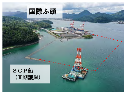
舞鶴国際ふ頭Ⅱ期整備
