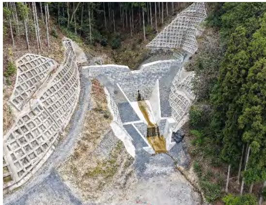
中ノ谷川（宇治田原町）砂防えん堤
