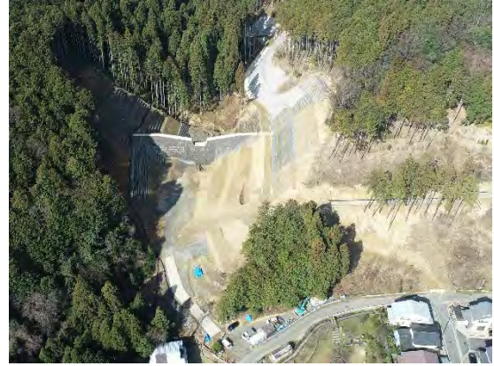
蛙ヶ谷川（京都市北区）砂防えん堤
