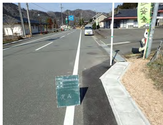
完成（側溝蓋の設置）
